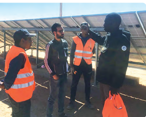
Der Bau der Solarpaneele ist im Frühling 2020 fast komplett abgeschlossen und wird das Gelände mit Öko-Strom versorgen.
